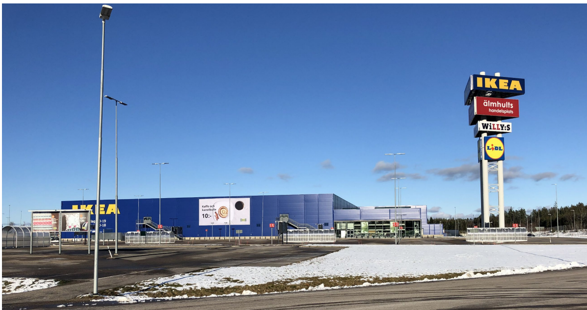
Bild 20. IKEA-varuhuset. Sett från söder.
